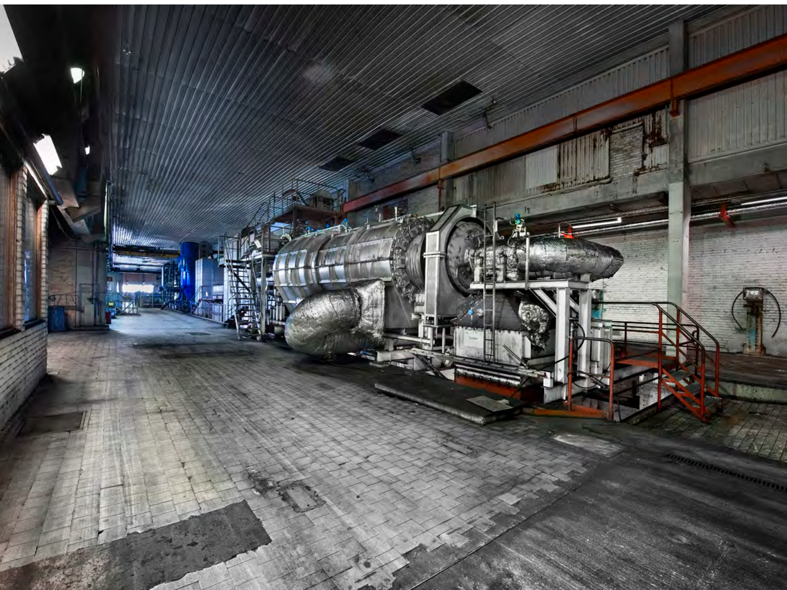
Inifrån anläggningen i Åsensbruk.
